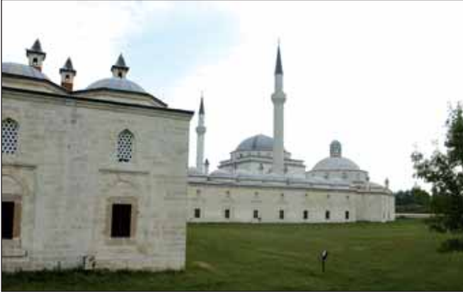
Resim 1: II. Beyazıt Külliyesi'nin görünümü.
